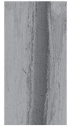
(d) Groove pointing
