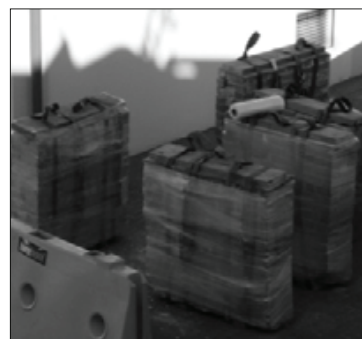
(d) Wrapping wall panels with protective plastic
